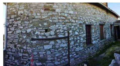
Τοίχος βόρειας όψης
