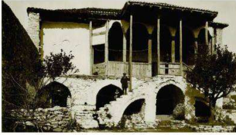
1. τυφλά τοξωτά κοιλώματα στην δυτική όψη (1915-17: η πρώτη παλαιότερη φωτογραφία)
