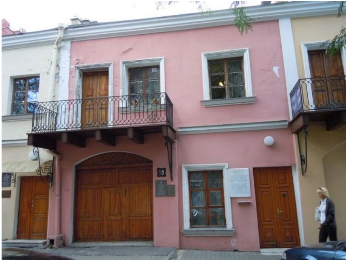
Το σπίτι της Φιλικής Εταιρείας στην Οδησσό (σύγχρονη όψη, 2015-2016 περίπου) Krasnyi Pereulok 18, Οδησσός. Αρχείο Wikimedia Commons © Yuriy Kvach, CC BY-SA 3.0. Η σύγχρονη φωτογραφία αποτυπώνει την αναστηλωμένη όψη του ιστορικού κτιρίου όπου ιδρύθηκε η Φιλική Εταιρεία, επιβεβαιώνοντας την διαχρονική του σημασία στην ελληνική διασπορά.
