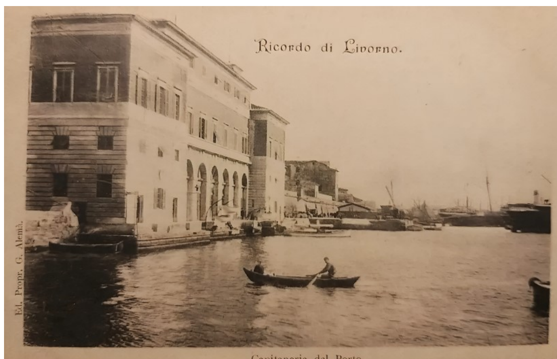
Εικ. 4. Το κτήριο της Capitaneria (Διεύθυνση του Λιμανιού) στο Λιβόρνο.
