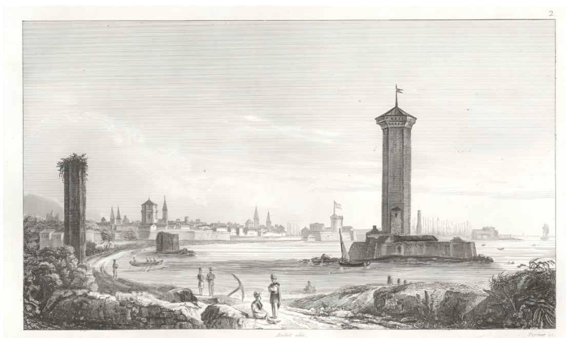
Εικ. 2. Αποψη του παλιού λιμανιού του Λιβόρνο με τον φάρο της Fortezza Vecchia. Χαρακτικό του 18ου αιώνα που αποδίδει την είσοδο του λιμένα και τα αμυντικά του έργα, πριν από τις μεγάλες παρεμβάσεις του 19ου αιώνα.
